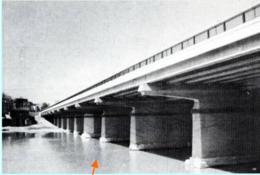
Puente de la Almozara. Ampliación (1987). Zaragoza.
