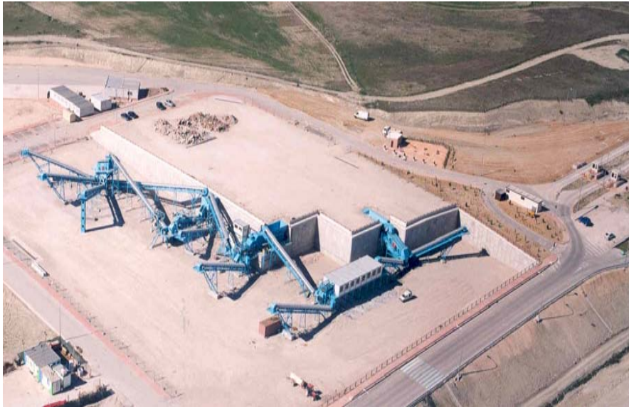
Centro de tratamiento de RCDs La Salmedina (Madrid)
