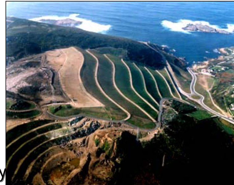
Vertedero de Bens (La Coruña)
