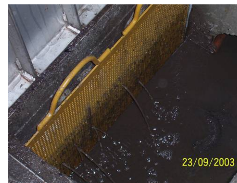
Descarga de barreduras, decantación y filtración del agua escurrida
