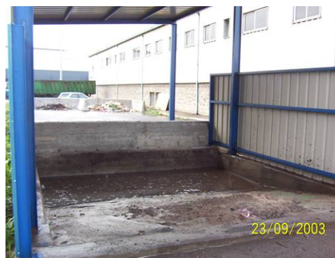
Descarga de barreduras, decantación y filtración del agua escurrida
