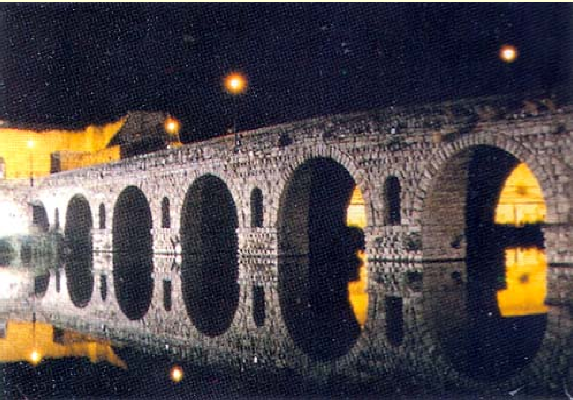
Puente Romano de Mérida 1ª iluminación artística
