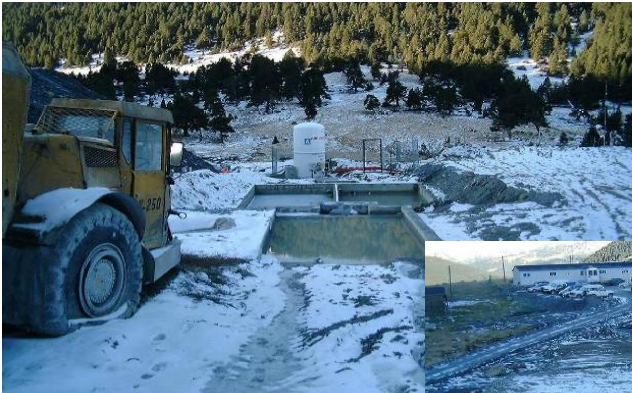
Neutralización del pH del efluente de un túnel mediante inyección de CO<sub>2</sub>
