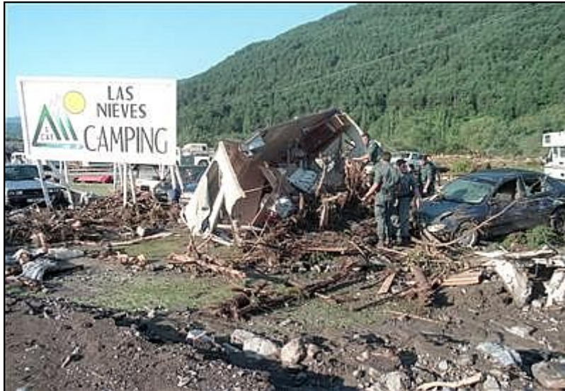
Fig. 4. Efectos de la crecida repentina del barranco de Arás (1996) sobre el Camping Las Nieves, en Biescas (Huesca). Foto: Agencia EFE
