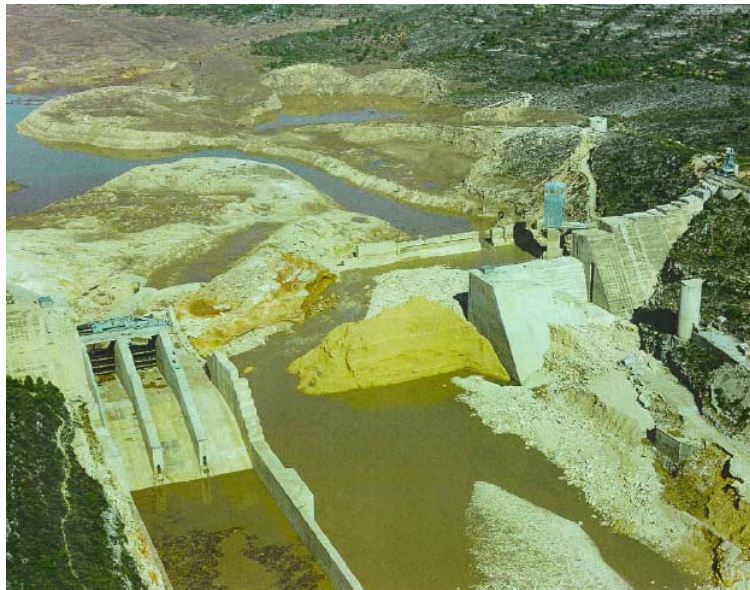
Fig. 5. La presa de Tous después de su rotura durante la avenida del Júcar de 1982.
