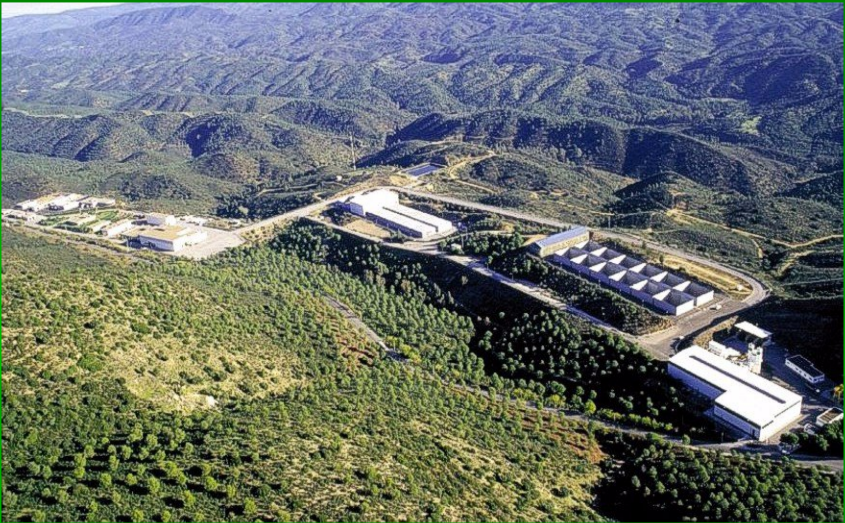
VISTA AÉREA DE LA INSTALACIÓN
