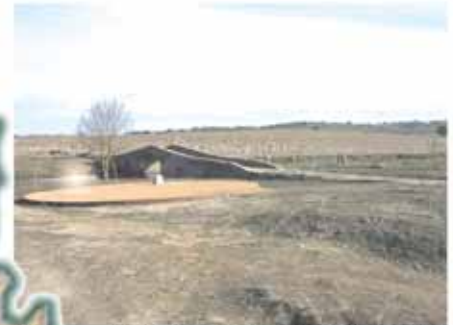
Puente medieval. Via de la Plata. Cordel de Mérida Aldea del Cano
