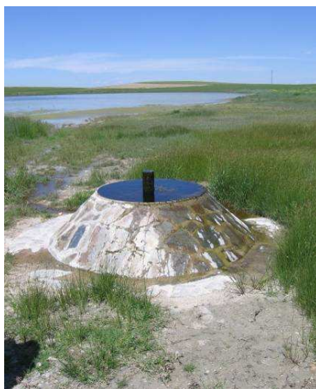
Figura 5. Regeneración hídrica de la laguna de la Iglesia en mayo de 2005 y detalle del dispositivo de entrada (conocido como “hongo”). Laguna de la Iglesia, Coca (Segovia).
