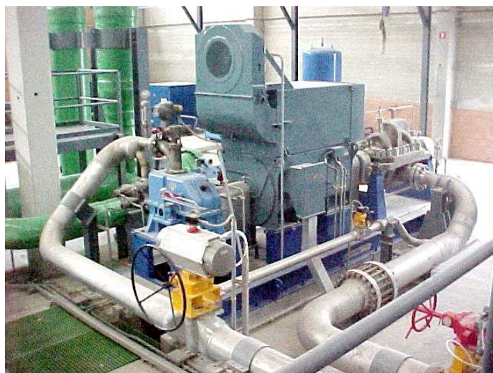
Figura 2 Grupo de alta presión Desalinizadora de Carboneras
