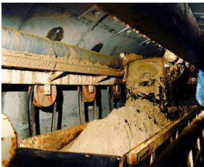
Extracción de material de excavación por cinta. Túnel del colector de Avilés
