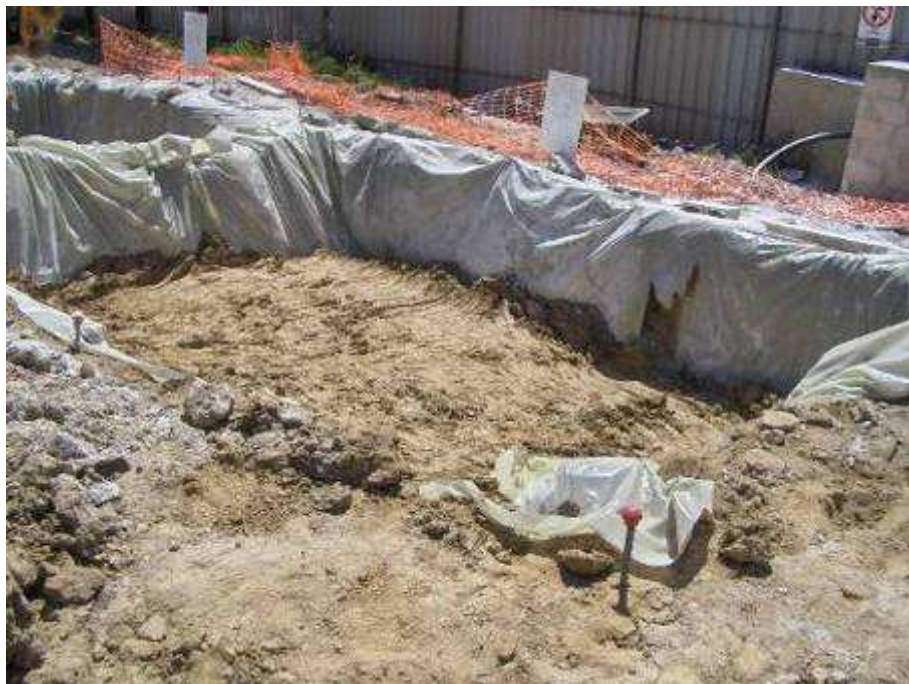
Foto 11: Reparto en balsa de la mezcla al 2%
