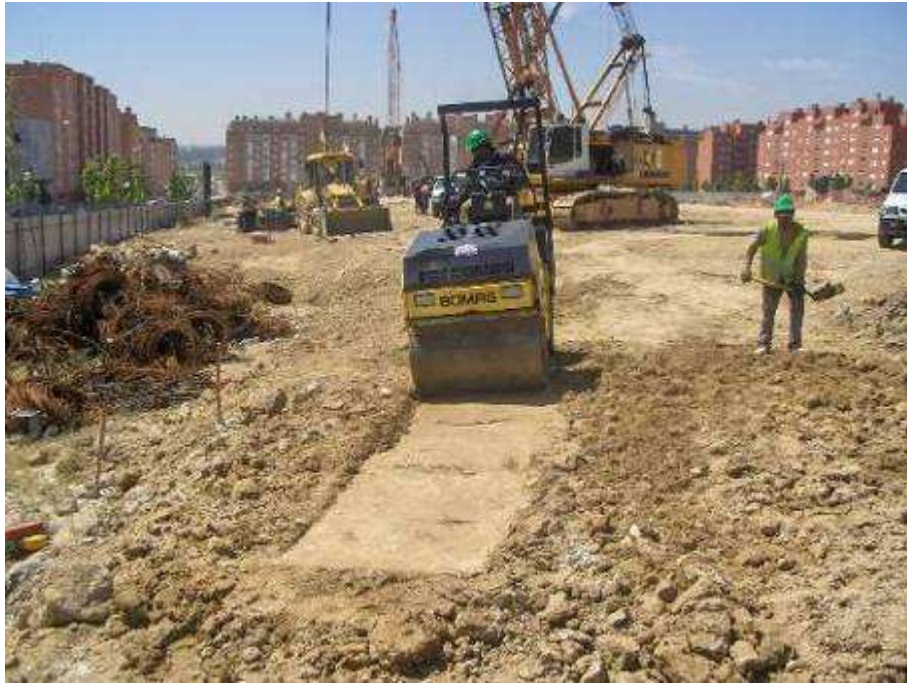
Foto 20: Compactación de la mezcla
