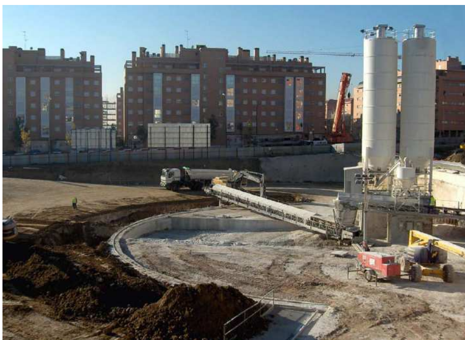
Foto 22: Foso de tratamiento de lodos de la línea 11
