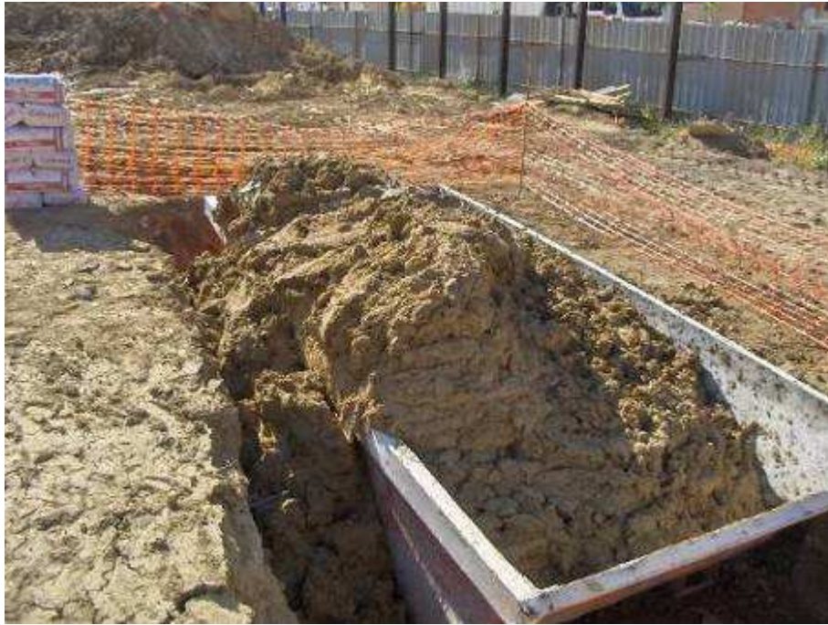
Foto 14: Descarga de lodos en el contenedor.
