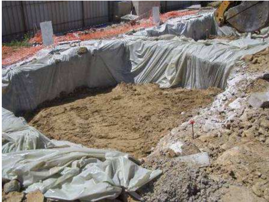
Foto 10: Reparto en balsa de la mezcla al 1%
