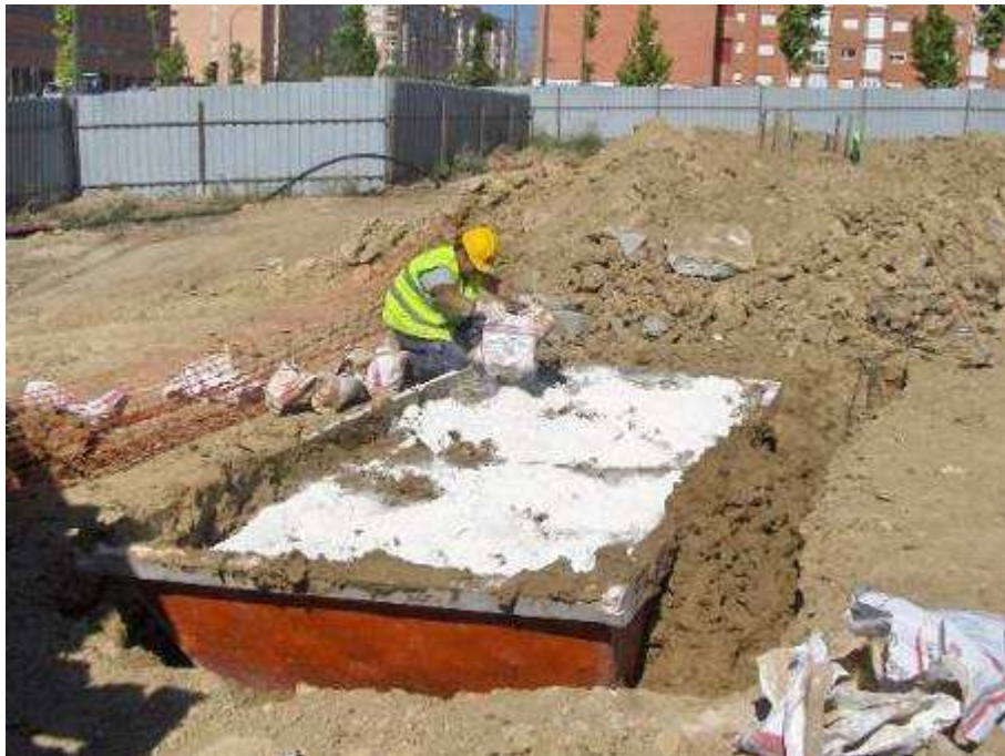
Foto 15: Proporción de cal en el contenedor para la mezcla al 2 %
