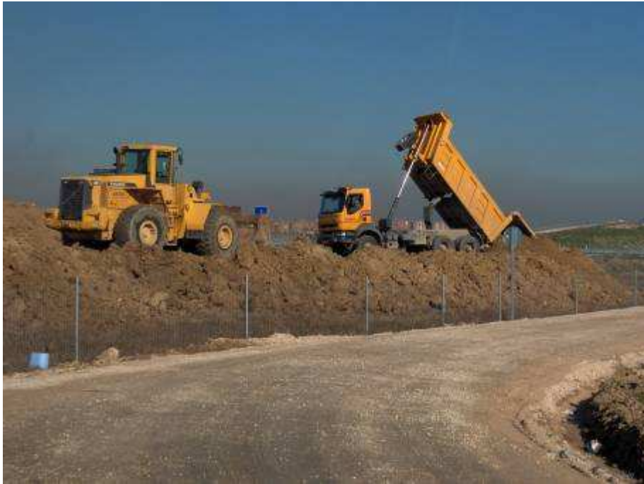
Foto 24: Realización de caballones en la Radial 5 con lodos tratados con cal de la línea 11
