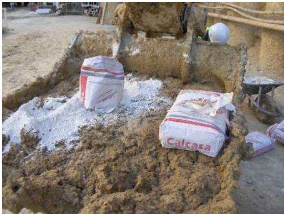
Foto 7: Proporción de cal en cada cazo para la mezcla al 1 %.
