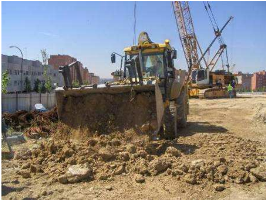
Foto 19: Extendido de la mezcla
