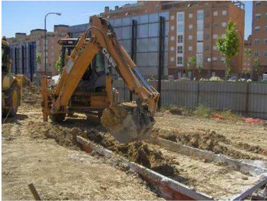
Foto 18: toma de la muestra para su extendido y compactación
