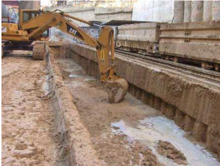
Foto 6: Retroexcavadora tomando muestra para la prueba
