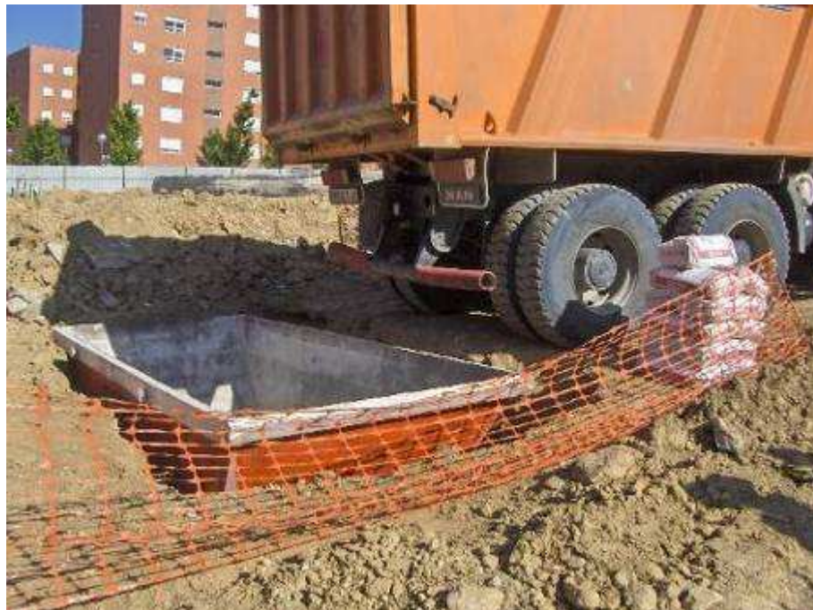
Foto 13: Colocación de un contenedor a ras de suelo
