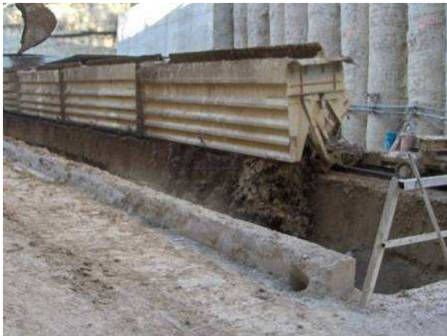
Foto 5: Descarga de lodos en pozo de Atocha
