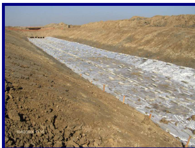
Figuras 12, 13 y 14. Vista del efluente de uno de los vaciaderos. Medida correctora (mediante recubrimiento de plástico) para evitar sólidos en suspensión. Detalle de uno de los cajones de agua.
