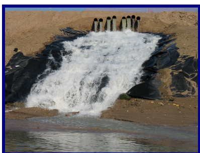
Figuras 12, 13 y 14. Vista del efluente de uno de los vaciaderos. Medida correctora (mediante recubrimiento de plástico) para evitar sólidos en suspensión. Detalle de uno de los cajones de agua.
